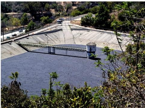
Die Installation ist unglaublich schnell und einfach. Im Wasser kann die zusätzliche Stabilität Windgeschwindigkeiten von mehr als 80 km / h (22 m / s) bewältigen, ohne das die Kugeln von der Oberfläche geblasen werden.
